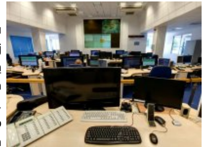
Stoleczne Stanowisko Kierowania - sala operacyjna
